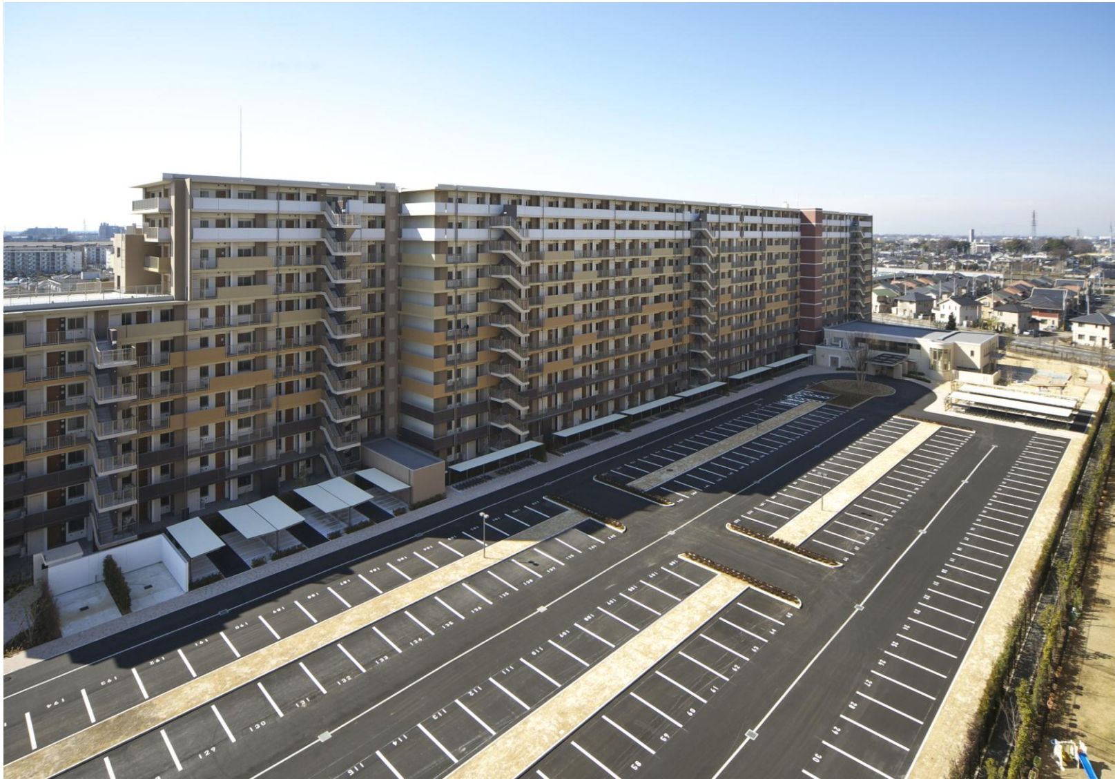
工事名称:レーベンスクエア東鷲宮2新築工事 工事場所:埼玉県久喜市 元請会社:安藤建設 株式会社 工 期:平成22年1月～平成23年3月
