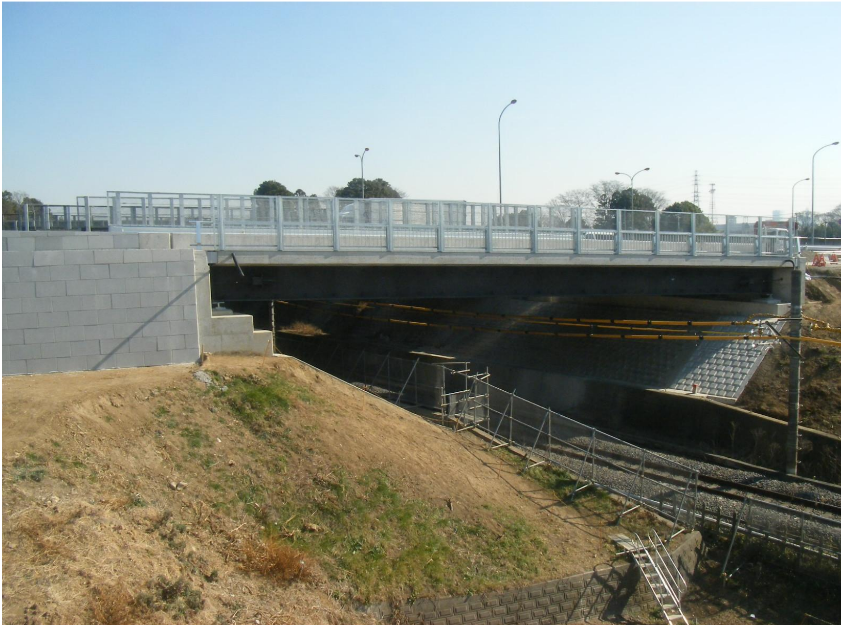
工事名称:川越線日進指扇間宮前弧線橋改築工事 工事場所:埼玉県さいたま市 元請会社:東鉄工業 株式会社 工 期:平成21年4月～平成22年3月
