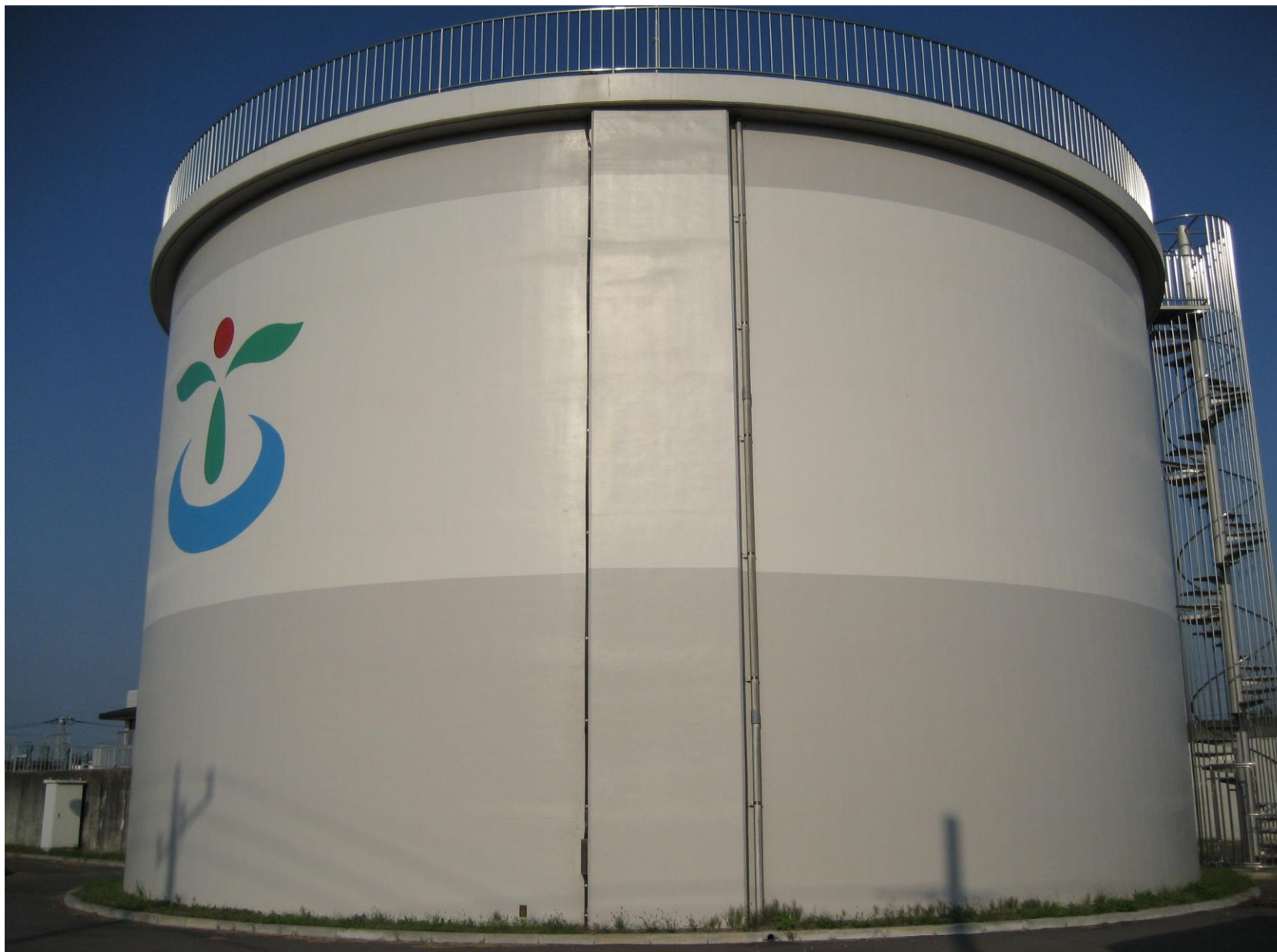
工事名称:三和町配水池築造工事 工事場所:茨城県古河市 元請会社:東亜建設工業(株)・(株)野口組特定建設業共同企業体 工 期:平成17年8月~平成18年5月
