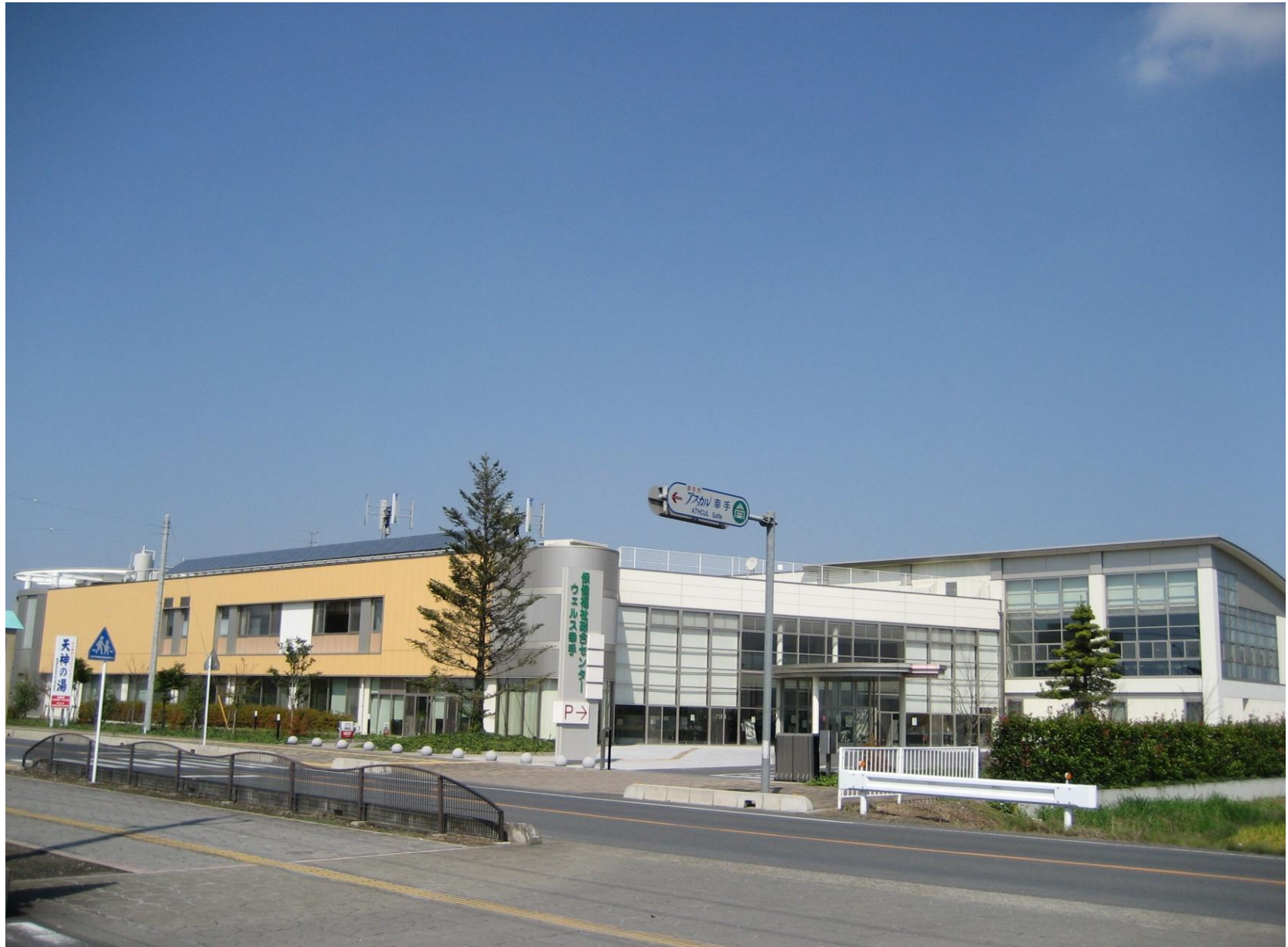
工事名称:幸手市保健福祉総合センター建築工事 工事場所:埼玉県幸手市 元請会社:株式会社 間組 工 期:平成15年12月～平成17年1月
