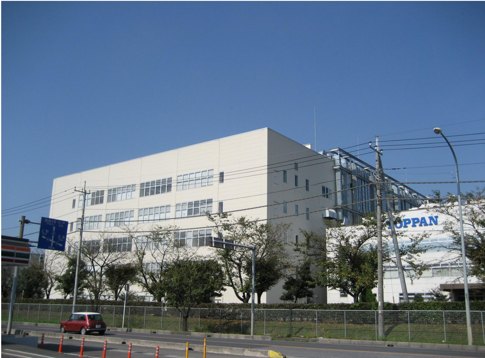
工事名称:凸版印刷幸手工場D棟新築工事 工事場所:埼玉県幸手市 元請会社:安藤建設(株)・東急建設(株)特定建設業共同企業体 工 期:平成18年10月～平成19年8月
